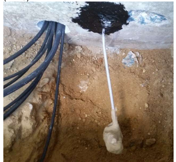
Bild 3: Handschachtung für Schachtgrube
