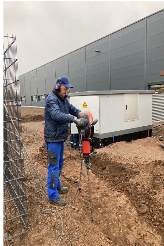
Bild 6: Eintreiben eines Tiefenerders mittels Vibrationshammer
