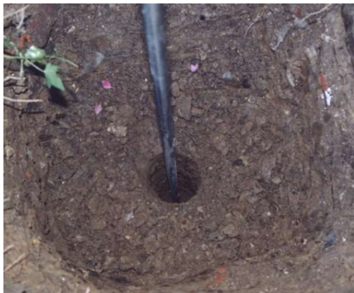
Bild 4 Schachtgrube mit Bohrloch für die Montage von Tiefenerdern
